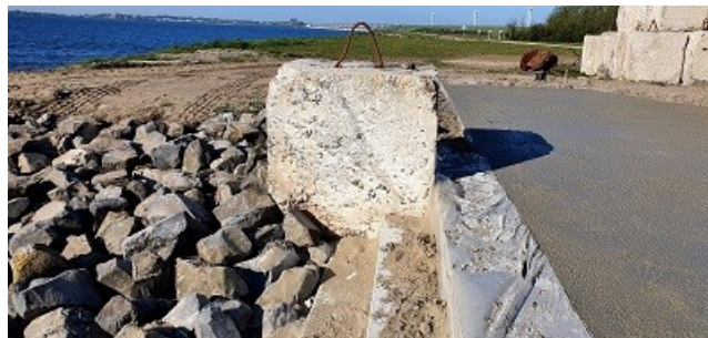
Foto: Betonblok aan het einde van de boulevard
