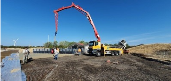
Foto: Aanleg entreeplein bij Boelies
