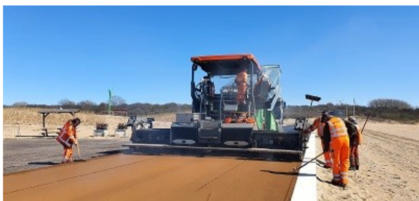
Foto: Aanleg nieuw asfalt
